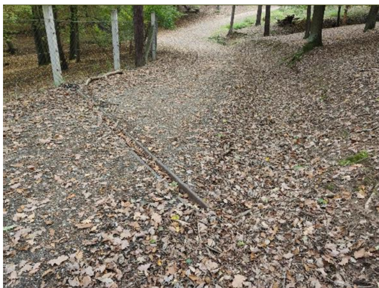
Zanesená svodnice v extravilánu
