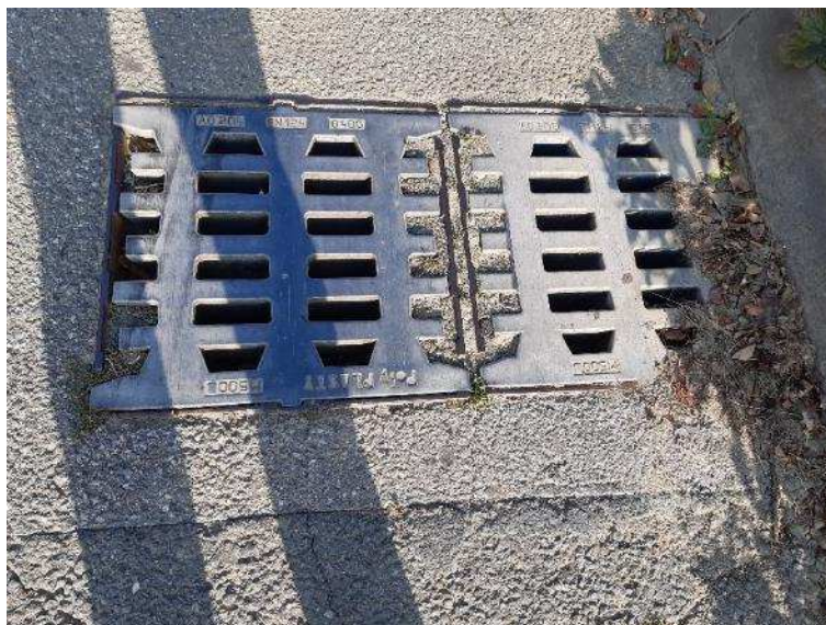
Stávající dešťové vpusti v intravilánu
