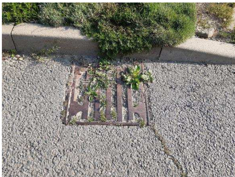
Zanesená dešťová vpust v intravilánu na ulici Březová
