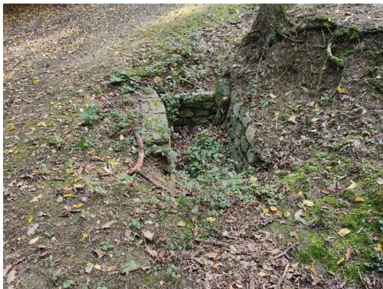
Zanesený vtokový objekt do propustku u brány do Holedné
