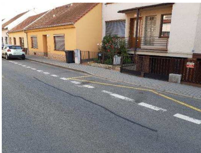
Kritický profil – zaplavovaná garáž při přívalových deštích
