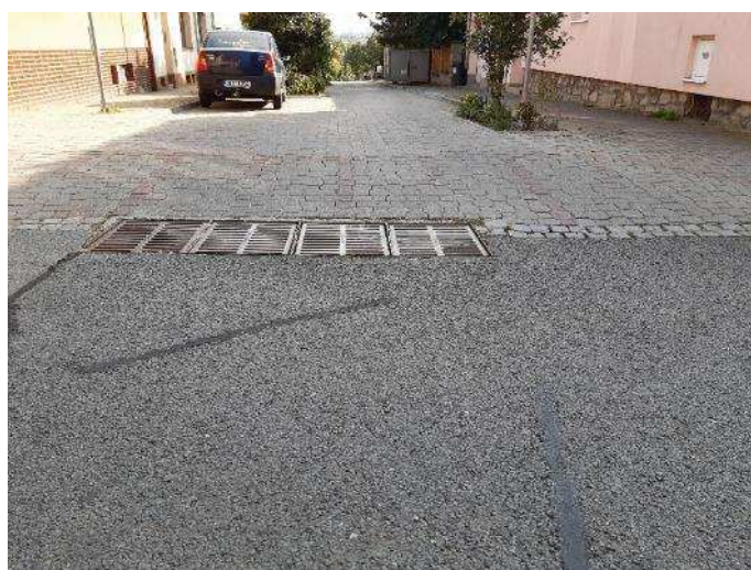
Dešťové vpusti na ulici Lelkova
